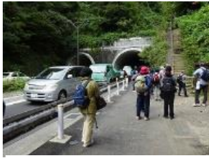
大仏切通下の隧道
