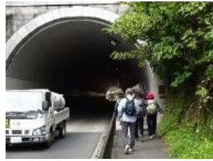
大仏切通下の隧道に入る
